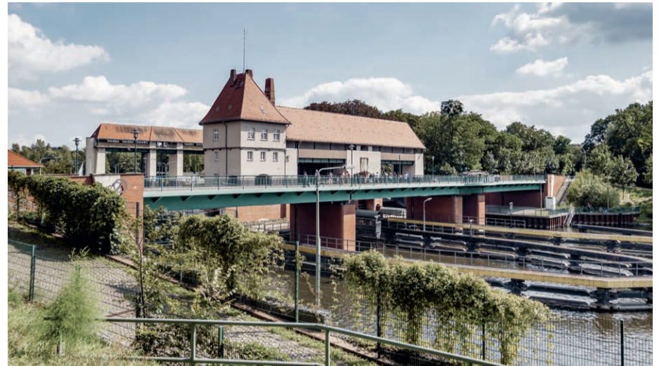
Denkmalgeschützte Schleusenanlage des Brandenburg-Berliner Teltowkanals
